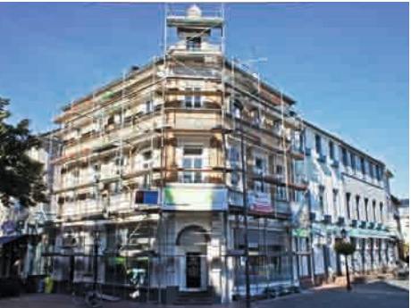
Historische Fassade freigelegt: das Wohn- und Geschäftshaus Alter Markt 2
