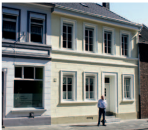
Mit Fördermitteln in Eigenleistung restauriert: Fassade Kreuzherrenstr. 5
